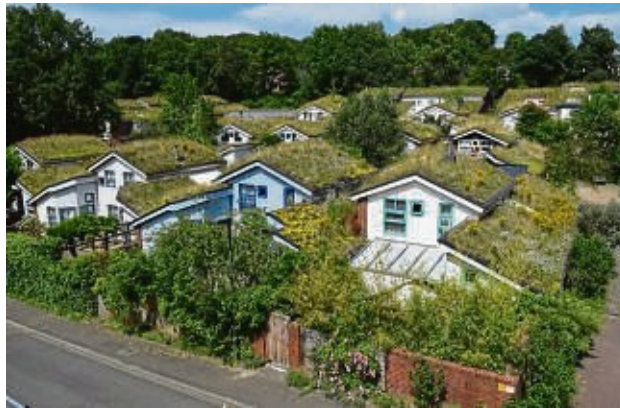
Mit bepflanzten Dächern können auch Gebäude ein Biotop sein.
