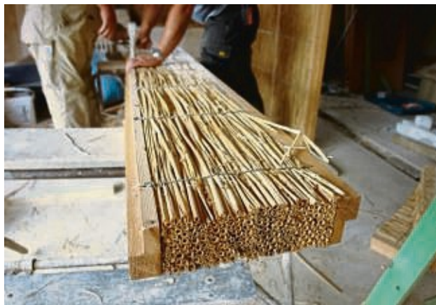
Mehr als ein Sichtschutz am Balkon: Schilf kommt auch als Dämmmaterial zum Einsatz.
